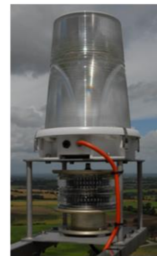
Figure 63 : exemple de balise, feux à éclats blancs et rouges (VALOREM)
