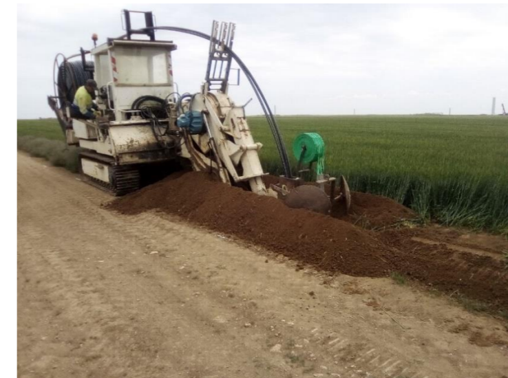
Photo 150 : pose d'un câble HTA à 1,20 m à partir d'une trancheuse (source VALOREM)
