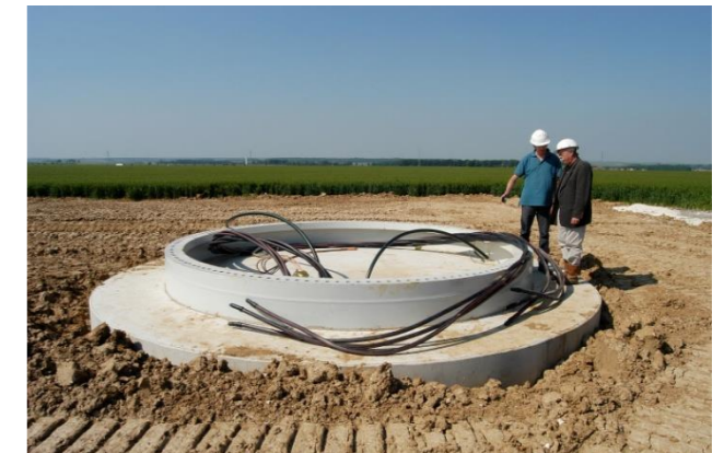
Photo 154 : fondation terminée (VALOREM)
