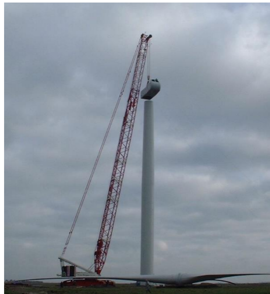
Photo 157 : installation de la nacelle (VALOREM)
