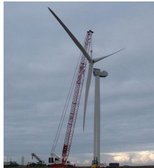
Photo 158 : mise en place du rotor tripale (VALOREM)
