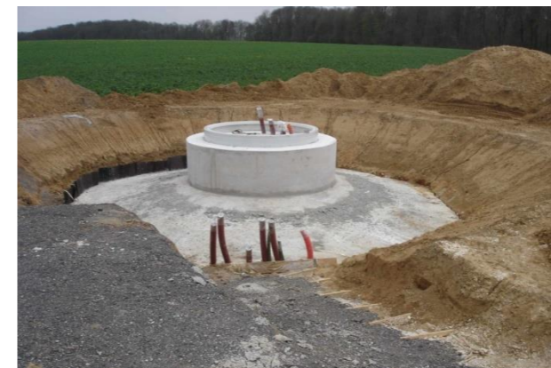
Photo 153 : béton terminé (VALOREM)
