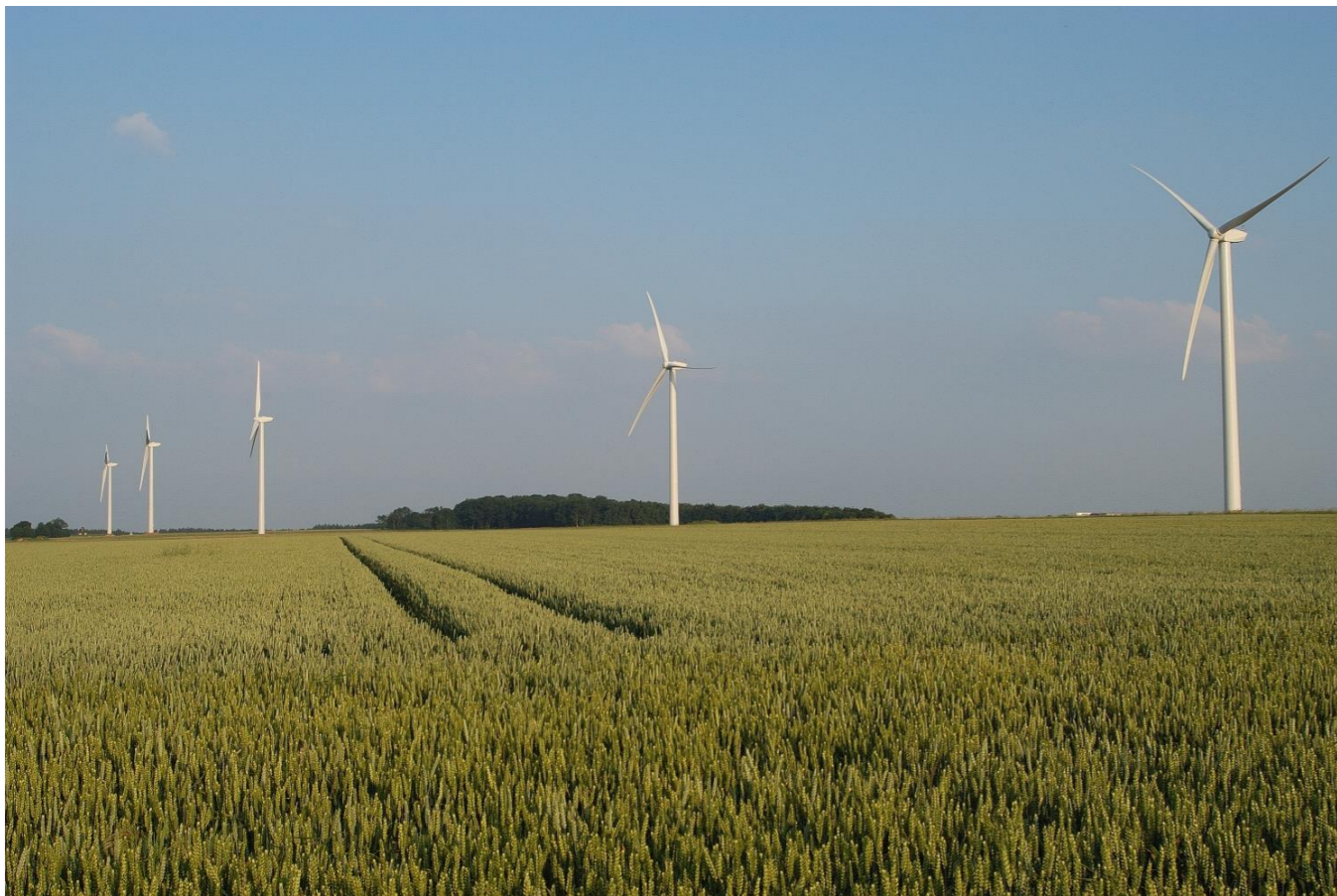
Photo 144 : vue générale d'un parc éolien en plaine (VALOREM)
