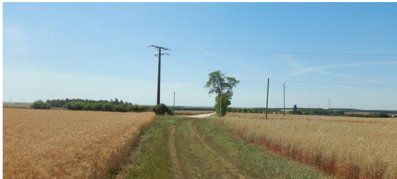
Photo 163 : ligne électrique HTA aérienne longeant la route communale
