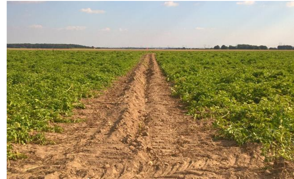
Photo 149 : tranchée pour le passage de réseau électrique HTA à partir d'un soc tracté (Source : VALOREM)
